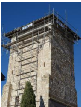
Travaux en cours 2 ème tranche 1er trimestre 2018 : 11 817 € HT
